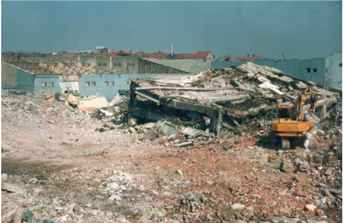
1993 Kazlıçeşme Deri Fabrikası Yıkımı
